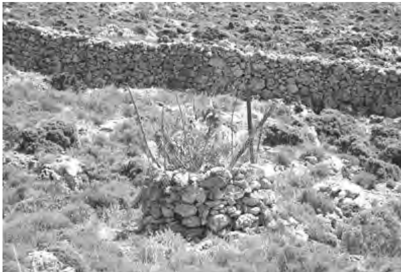
Εικ. 35: Κυκλική περίφραση από ξερολιθιά για την προστασία δένδρου συκιάς (δενδρόσπιτο), δεξιά του δρόμου που συνδέει τον οικισμό Βαθύ με την τοποθεσία Σταυρός . Ο προστατευτικός ρόλος της περίφραξης ενισχύεται με την τοποθέτηση μεταλλικού πλέγματος στο πάνω μέρος της περίφραξης (2010).
