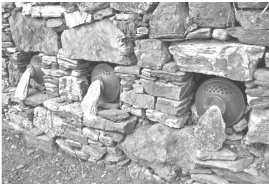
Εικόνα 4. «Δυνβέλια». Πήλινες κυψέλες τοποθετημένες σε αναλημματικούς τοίχους αναβαθμίδων.
