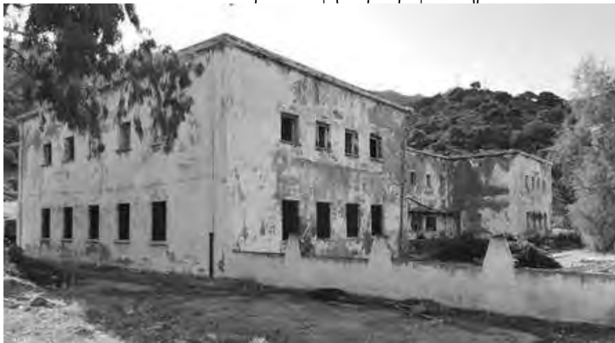
Εικ.38. Βόρεια άποψη διώροφου κτηρίου
