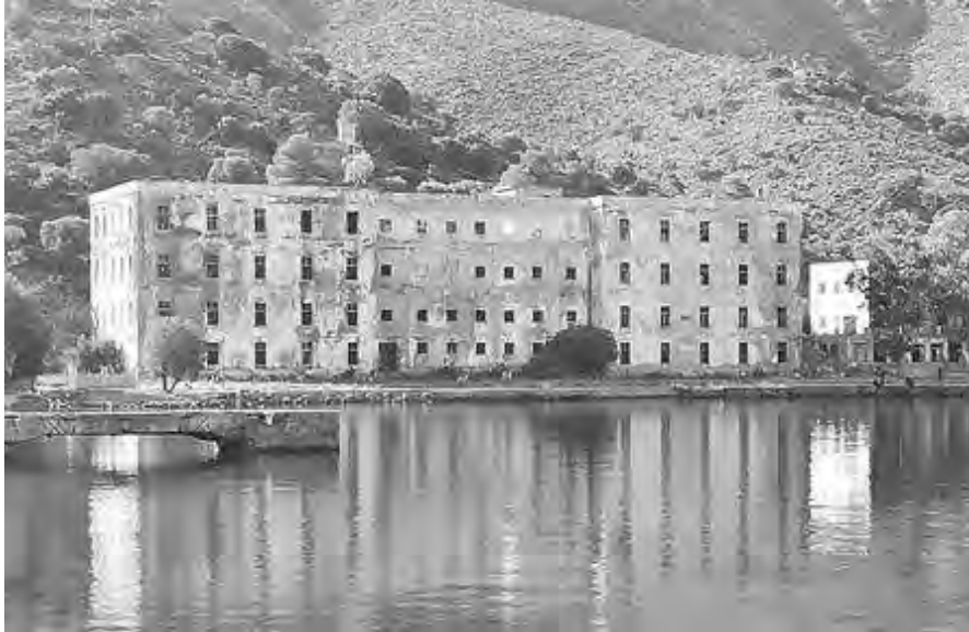
Εικ.37. Βόρεια άποψη τετραώροφου κτηρίου
