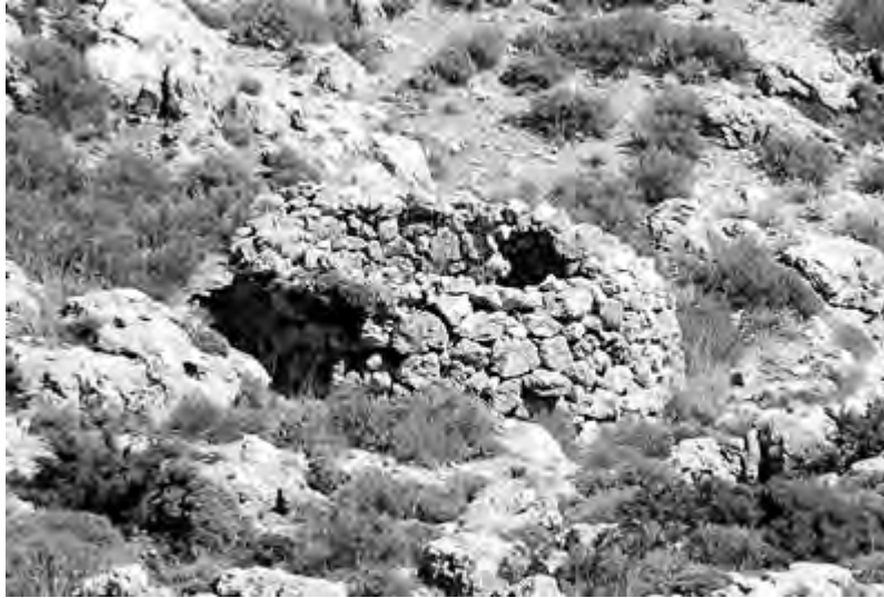
Εικ. 34: Κυκλική περίφραξη από ξερολιθιά για την προστασία δένδρου συκιάς (δενδρόσπιτο), δεξιά του δρόμου που συνδέει τον οικισμό Βαθύ με την τοποθεσία Σταυρός . Διακρίνεται μεταλλικό πλέγμα τοποθετημένο περιμετρικώς του δένδρου, για πρόσθετη προστασία από τις επιθέσεις των ζώων (2010).
