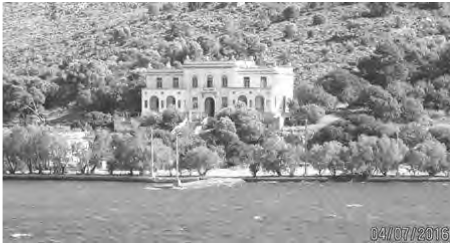
Εικ.30. Άποψη του κτηρίου Διοίκησης στα Λέπιδα
