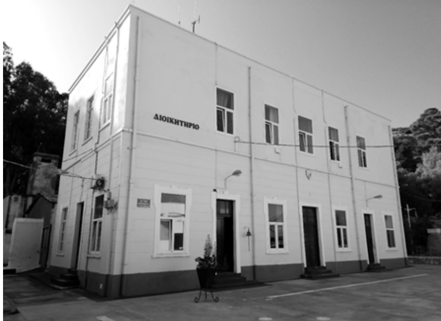
Εικ.39. Το Διοικητήριο του Ναύσταθμου
