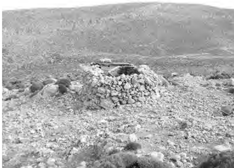
Εικ. 56: Κτίσμα από ξερολιθιά με πιθανή χρήση εποχικού καταλύματος ή σταύλου αριστερά του δρόμου προς τον όρμο Παλιόνησος (2019).
