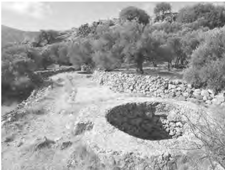
Εικ. 41: Γενική άποψη των δύο πηγαδιών τα οποία βρίσκονται σε κτήμα κοντά στο ξωκλήσι της Αγίας Τριάδας, στα ανατολικά του Κάστρου της Χώρας (2019). Βρίσκονται σε πλάτωμα μήκους 24,00 μ., έχουν καθαρό βάρος 10.50 μ. και διάμετρο 2,80 μ. ενώ φέρουν στηθαία ύψους 0.85 μ. (2019).
