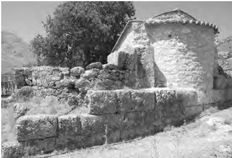
Εικ. 72: Το βυζαντινό ξωκλήσι του Ταξιάρχη Μιχαήλ στην τοποθεσία Έμπολα, στον οικισμό Βαθύ έχει θεμελιωθεί πάνω σε αρχαιότερο μνημείο, από το οποίο σώζεται τμήμα τοιχοποιίας «εν ξηρώ» με επιμελώς κατεργασμένους ογκόλιθους (2010)
