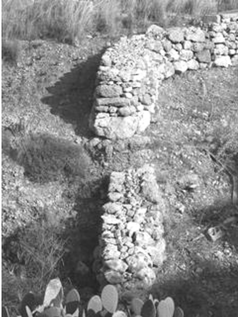
Εικ. 28, 29, 30: Χαμηλός φράχτης χτισμένος αποκλειστικά από ξηρολιθοδομή, με ιδιαίτερος επιμελημένη κατασκευή, σε ρέμα κοντά στον οικισμό Βοθόνοι. Είναι χαρακτηριστικό το γέμισμα των κενών της ξηρολιθιάς με λιθαράκια, τα οποία διαμορφώνουν ένα είδος επίστεψης (2018).
