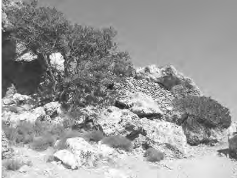
Εικ. 55: Συμπληρωματική κατασκευή από ξερολιθιά για την κάλυψη ανοίγματος σε βραχώδη διαμπερή σχηματισμό (κέλυφος) στη νησίδα Τέλενδο (2018).
