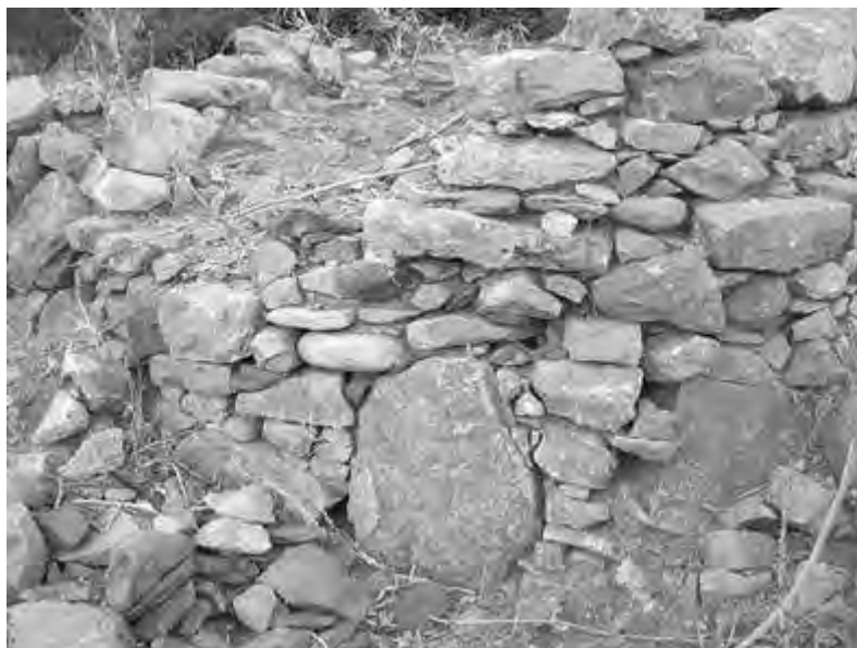
Εικ. 4. Βαί. Ερειπωμένος λιθόκτιστος φούρνος στον εγκαταλειμμένο οικισμό. Το άνοιγμά του παραμένει σφραγισμένο με πλακοειδή λίθο.
