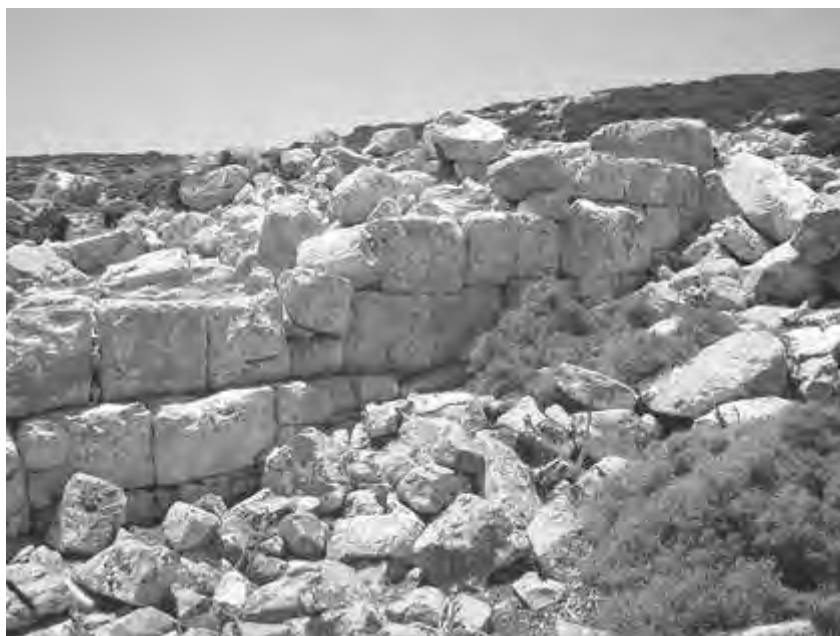
Εικ. 16. Βαθύ. Θέση «Χαράκια». Άποψη των ερειπίων του πύργου.
