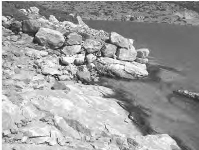
10. Η λαξευμένη αναβάθρα Π8 και οι ογκολιθικοί τοίχοι εκατέρωθεν διαμορφώνουν εγκαταστάσεις λιμενικού και ίσως αμυντικού χαρακτήρα.
