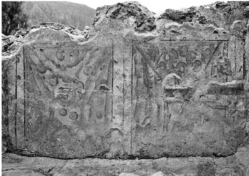
Εικ. 15. Βαπτιστήριο Παλαιοπαναγιάς – νότια πλευρά. Τοιχογραφία με απεικόνιση ορθομαρμάρωσης. Φωτογραφία Μ. Κουτελλάς
