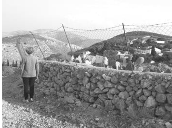
Εικ. 26: Σύγχρονη κατασκευαστική λύση για φράχτη περίφραξης κτήματος, δίπλα από τις εγκαταστάσεις του μοναστηριού της Αγίας Αικατερίνης. Η κατασκευή συνδυάζει ξηρολιθοδομή, επίστεψη από τσιμέντο, μεταλλικούς στύλους και μεταλλικό πλέγμα (2018)
