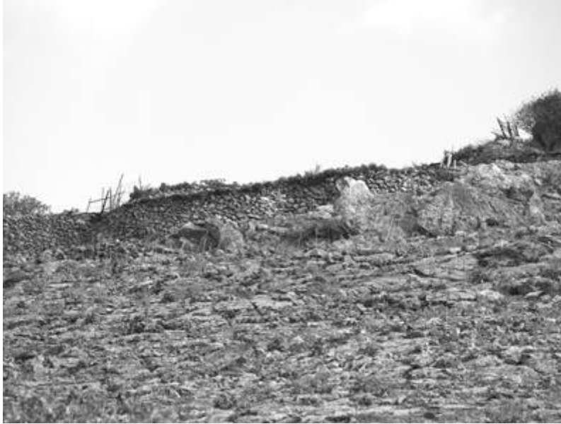
Εικ. 32: Ψηλός φράχτης χτισμένος αποκλειστικά από ξηρολιθοδομή κοντά στο ξεκλήσι της Αγίας Τριάδας ανατολικά του Κάστρου της Χώρας, με επιμελημένη κατασκευή και επίστεψη από αγκαθωτούς θάμνους (2019)
