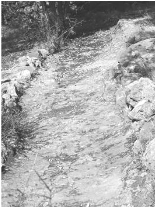
Εικ. 45, 46: Γενικές απόψεις των επιφανειών συλλογής του βρόχινου νερού, οι οποίες είναι επιστρωμένες με κονίαμα και διατηρούνται καθαρές από φερτά υλικά (2019).
