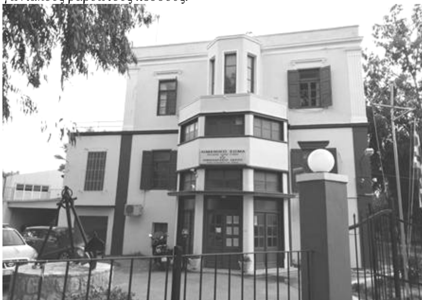
Εικ.10. Αρχοντικού, Ματταντού – Καυκαλίδη (σημερινό Λιμενικό Σώμα και Λιμεναρχείο)
