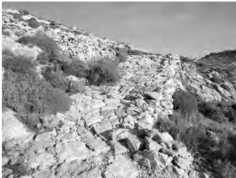
Εικ. 16: Το Ιταλικό Μονοπάτι , παρά την γενικά καλή του κατάσταση, σε πολλά σημεία παρουσιάζει φθορές λόγω της έλλειψης συντήρησης του λιθόστρωτου και των ξερολιθικών τοίχων αντιστήριξής του (2019).
