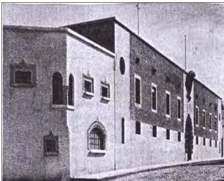
23. Palazzo dei lavori pubblici (Μέγαρο Δημοσίων Έργων). 1928, Αρχιτέκτων Florestano di Fausto.
