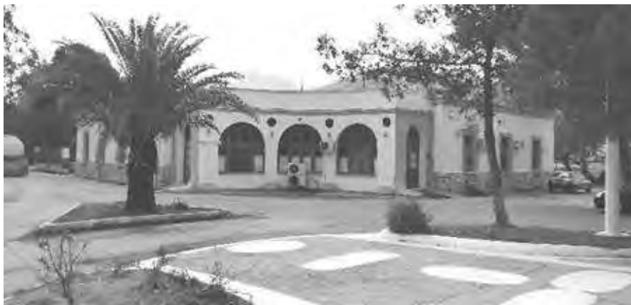
Εικ.35. Αίθουσα αναμονής επισκεπτών και ψυχαγωγίας στην Είσοδο της Βάσης στα Λέπινδα
