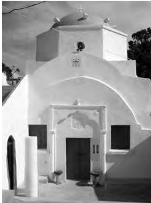
Εικ. 26. Φλεβαριώτισσα. Η πρόσοψη της εκκλησίας.
