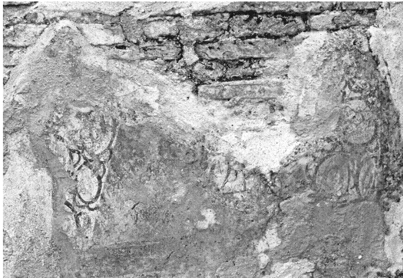
Εικ. 17. Βαπτιστήριο Παλαιοπαναγιάς – νότια πλευρά. Τοιχογραφία με απεικόνιση ορθομαρμάρωσης. Φωτογραφία Μ. Κουτελλάς
