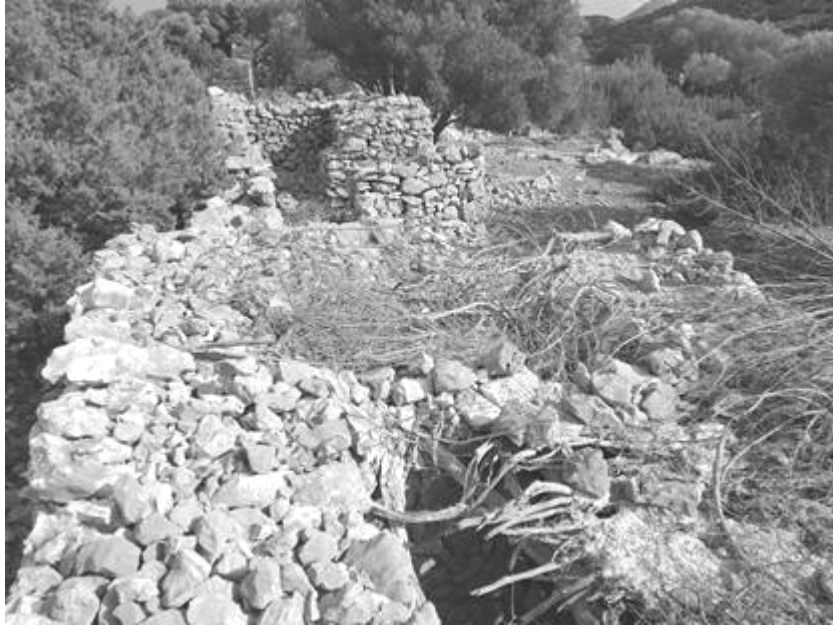
Εικ. 59: Οι κορμοί δένδρων, τα κλαδιά και το πατημένο χώμα, όπως σώζονται στα δώματα των κτισμάτων στην περιοχή με το τοπωνύμιο Στούμπος (2019).
