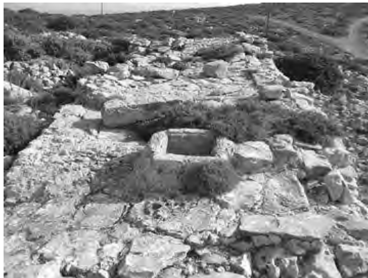
Εικ. 47. Καστελλάνος, θέση «Ζοφύρι». Στόμιο δεξαμενής στο πλακόστρωτο επάνω από το νότιο τμήμα του βόρειου κλίτους της βασιλικής.
