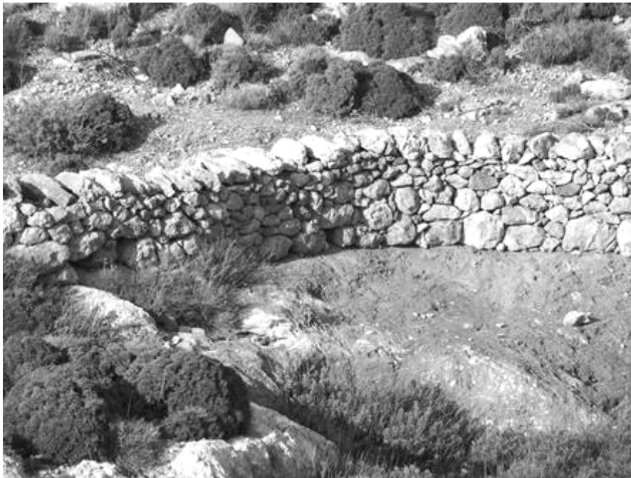
Εικ. 31: Χαμηλός φράχτης χτισμένος αποκλειστικά από ξηρολιθοδομή, κοντά στο μοναστήρι της Αγίας Αικατερίνης, με επιμελημένη κατασκευή και επίστεψη από κατεργασμένους μακρόστενους λίθους τοποθετημένους οριζόντια (2018).
