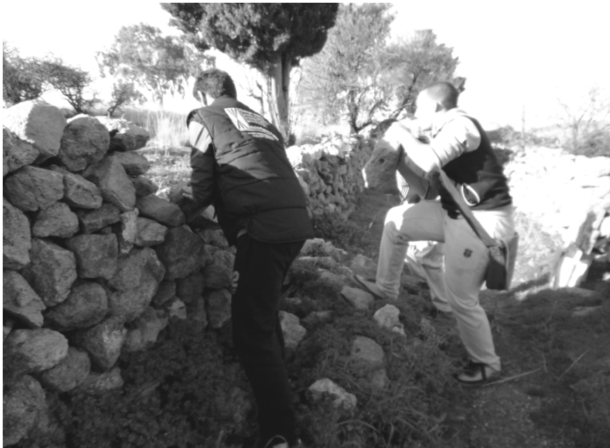
Εικόνα 12. Πάτμος, 2015. Επισκευή ξερολιθικού τοίχου από μαθητές της Γ΄ Γυμνασίου του Γυμνασίου Πάτμου.
