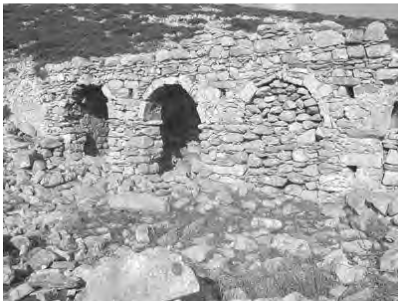
Εικ. 45. Καστελλάνος, θέση «Ζοφύρι». Άποψη του κεντρικού και βόρειου κλίτους της βασιλικής «Αγίου Γεωργίου»
