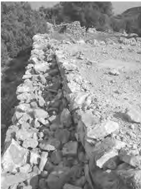
Εικ. 60, 61, 62: Η διπλή τοιχοποιία από ξερολιθιά στο προς βορράν πίσω μέρος των κτισμάτων, η οποία ταυτίζεται με τμήμα της περιφραξης του μεγάλου κτήματος στην περιοχή με το τοπωνύμιο Στούμπος (2019).
