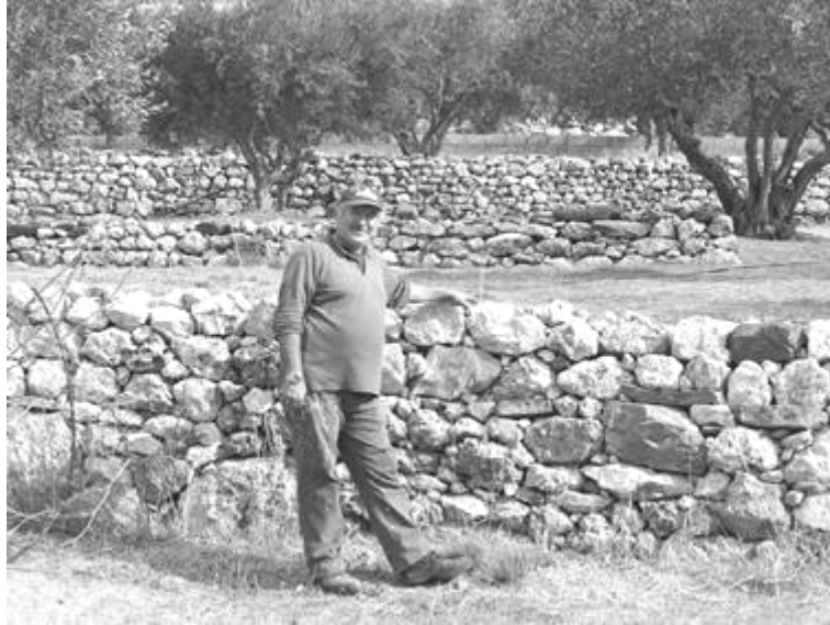
Εικ. 7. Ο Μιχάλης Κυράνης του Νομικού, ο οποίος συντηρεί και επεκτείνει τους αναλημματικούς τοίχους αντιστήριξης των αναβαθμίδων στον ιδιόκτητο ελαιώνα του, στην περιοχή Δάμος. Στο γειτονικό κτήμα στο βάθος διακρίνεται τοίχος αντιστήριξης από τσιμεντόλιθους αντί ξερολιθιάς (2019).
