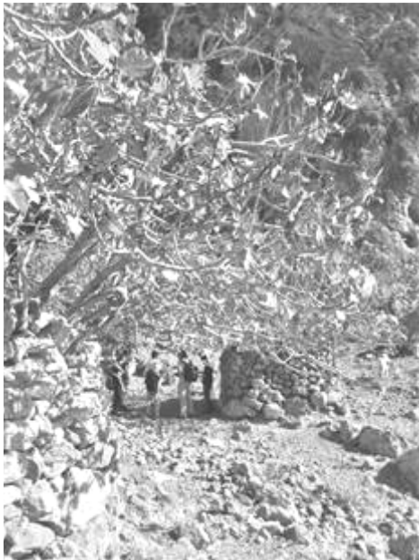
Εικ. 36, 37: Κυκλικές περιφράξεις από ξερολιθιά για την προστασία δένδρων συκιάς (δενδρόσπιτο) με περίπου 2,00 μ. ύψος, στην ορεινή περιοχή με το τοπωνύμιο Χοιρόμαντρες , στα ανατολικά του Κάστρου της Χώρας (Φωτ. Νίκης Καπελλά – 2016).
