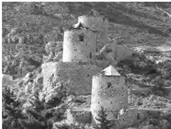
Εικ. 73: Οι τρεις ανεμόμυλοι που βρίσκονται στην πλαγιά ανατολικά του Κάστρου της Χρυσοχεριάς. Είναι εμφανής η χρήση ξηρολιθοδομής σε τοίχους αντιστήριξης, οι οποίοι ήταν απαραίτητοι στη διαμόρφωση του περιβάλλοντος χώρου (2018)
